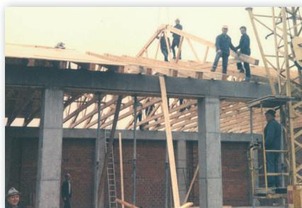
Errichten des Dachstuhls der Fahrzeughalle durch die Feuerwehrkameraden in Eigenleistung.
